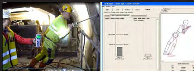
Figur 23 Installation av kamstålsbult i snett uppåtriktat läge. Maximal uppmätt tryckkraft 668 N. Biomekanisk simulering kompressionskraft i ländryggen uppgick till 2684 N (lägre än NIOSH rekommenderade insatsvärde).
